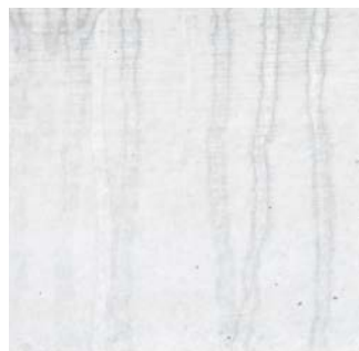
kurze Zeit der Witterung ausgesetzt
